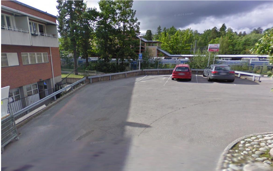
Figur 15. Lastnedfart på Tärningen 1 utrustad med kantsten och stödmur. Bilden tagen från Google streetview. ©Google
