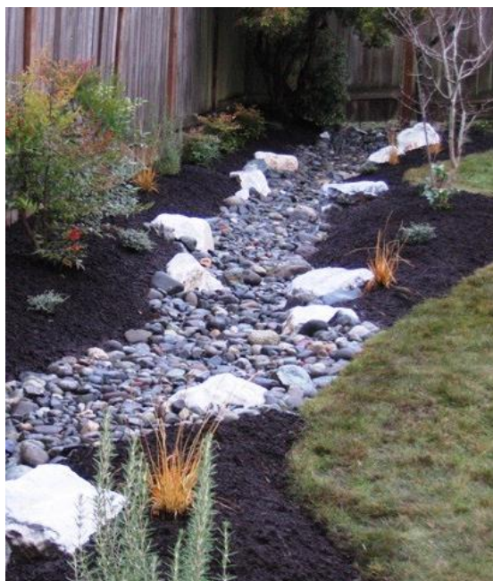
Figur 36. Exempel på avskärande dike/lågstråk i grönområde (t v) samt intill byggnad (t h). Foto: Bjerking AB.
